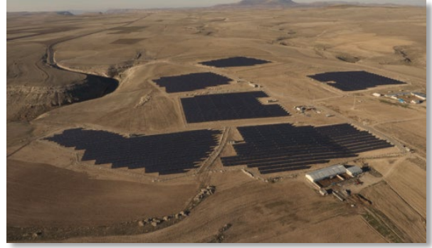
6.9 MWp – Yeşilhisar / Kayseri EPC Taahhüt Proje Yönetimi
